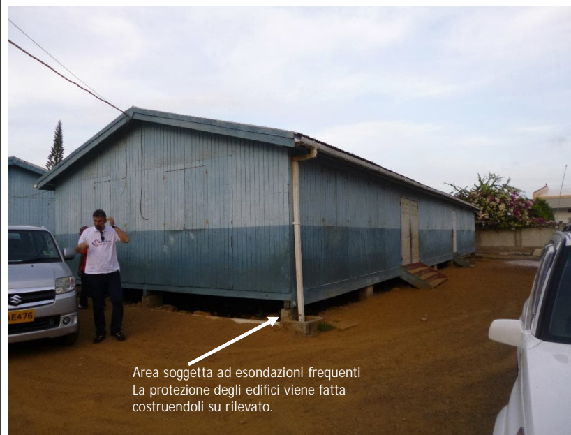
Scuole elementari di Grenville su palafitte per ridurre al minimo i danni causati dell'acqua alta.
